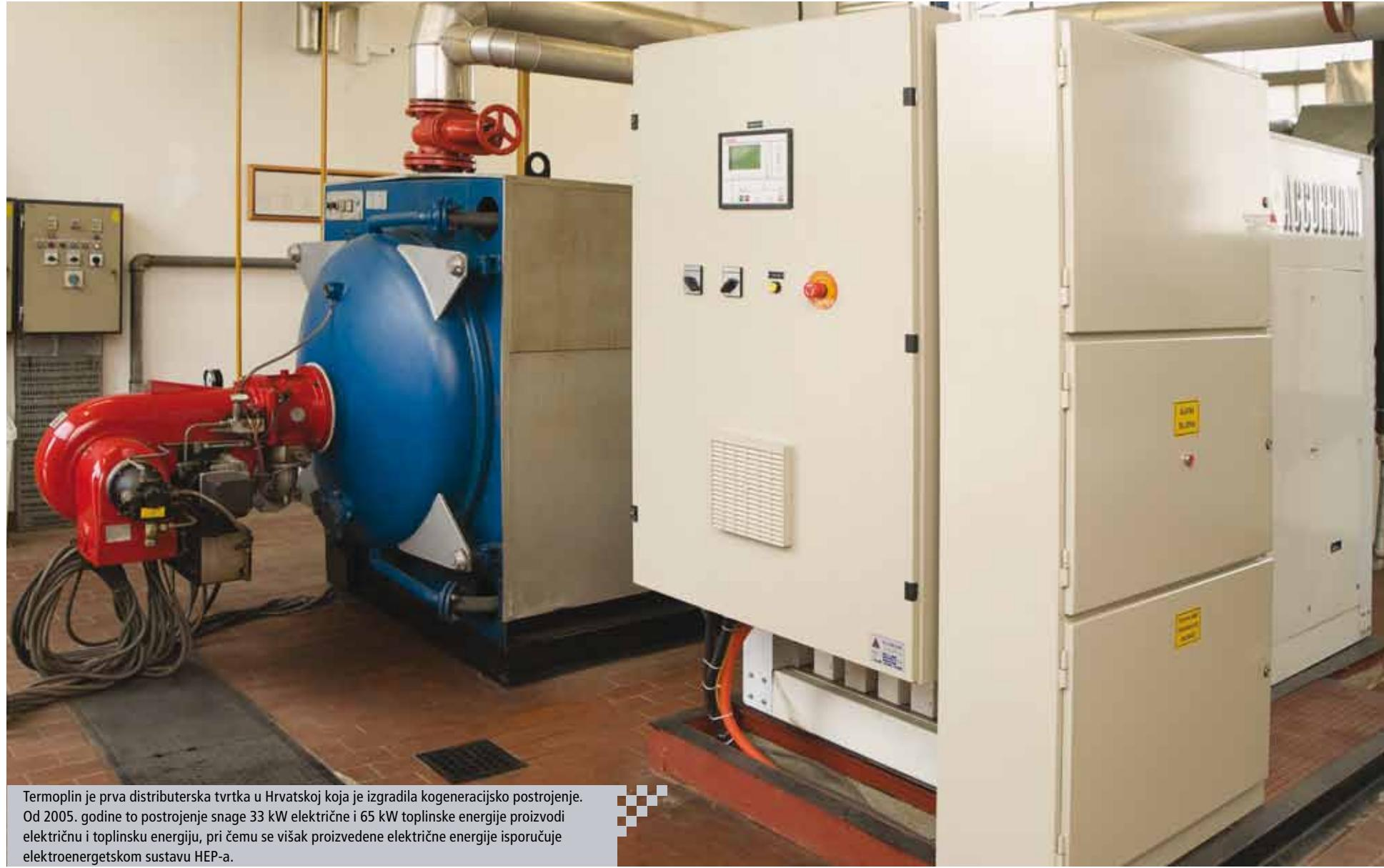
Termoplín je prva distributerska tvrtka u Hrvatskoj koja je izgradila kogeneracijsko postrojenje. Od 2005. godine to postrojenje snage 33 kW električne i 65 kW toplinske energije proizvodi električnu i toplinsku energiju, pri čemu se višak proizvedene električne energije isporučuje elektroenergetskom sustavu HEP-a.
