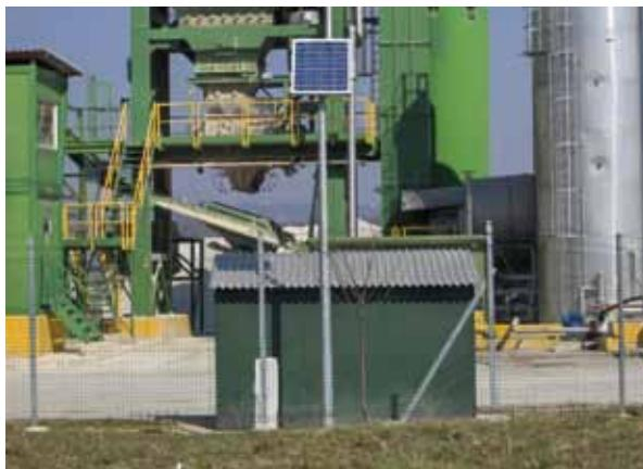
Slika 4. Mjerno-reducijska stanica s opremom za daljinsko očitanje
