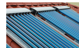
SOLARNI KOLEKTORI ZA PROIZVODNJU TOPLE VODE
